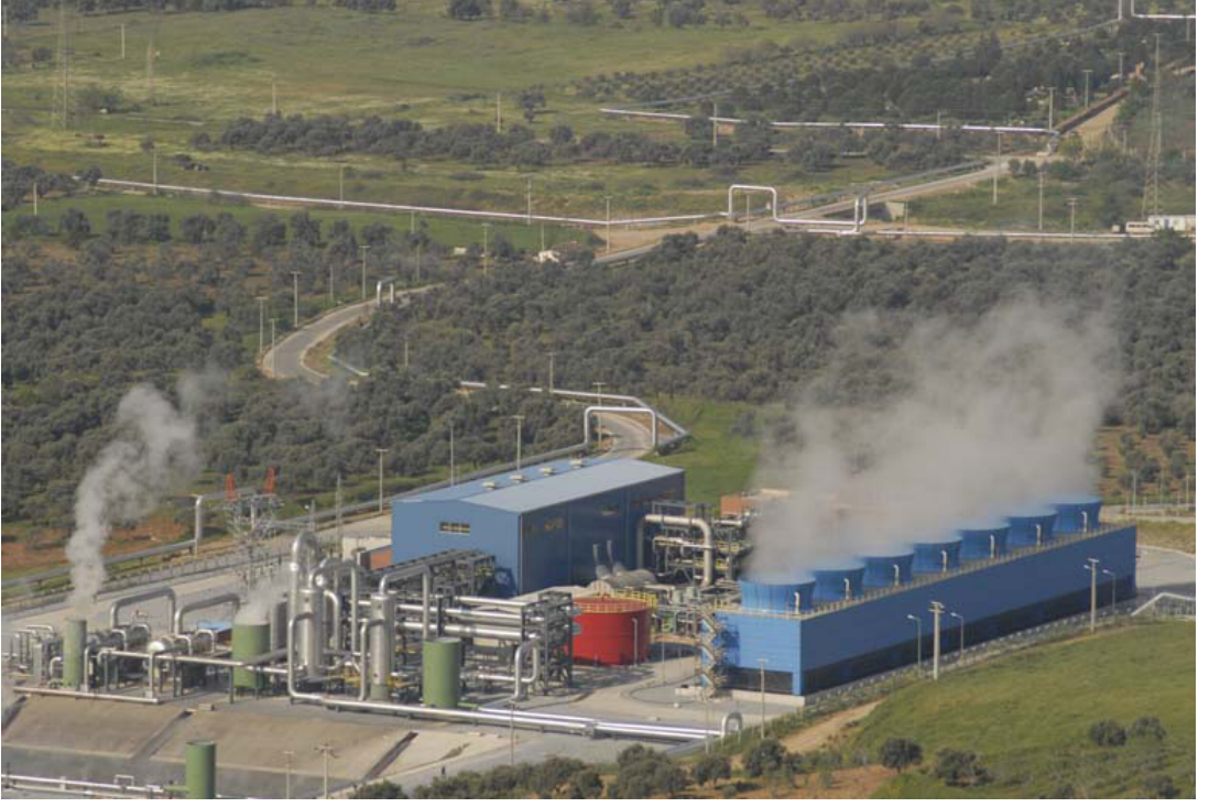
Fotoğraf 11 Tarım sahaları arasına kurulan jeotermal enerji santrali ve iletim hatları. (TMMOB Teknik Heyeti)
